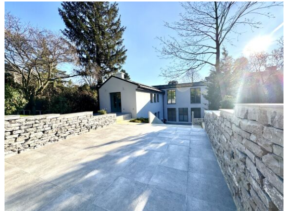
Blick von oberer Gartenterrasse auf das Haus
