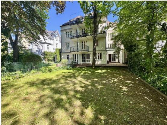
Ansicht vom Eigengarten zum Haus
