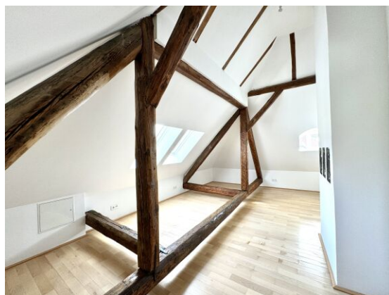
Raum im Dachgeschoss
